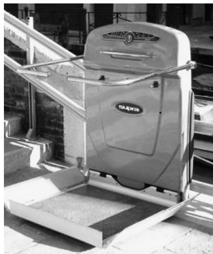
Подъемная платформа. Подъемник обеспечивает комфорт для тех, кто может передвигаться только в коляске. Платформа поднимает и перевозит кресло-коляску от тротуара до первого этажа
